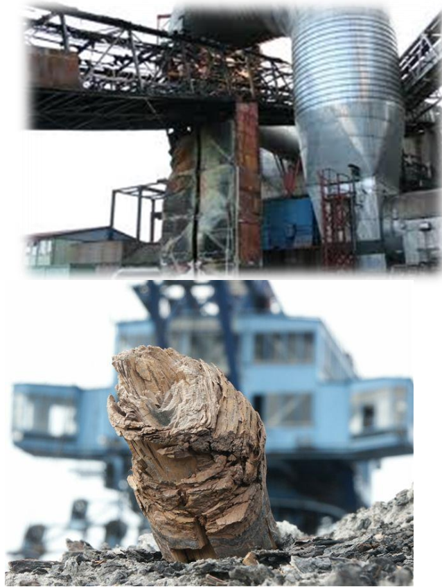
1. ábra: szénszállító leégett szalag rendszer 11
